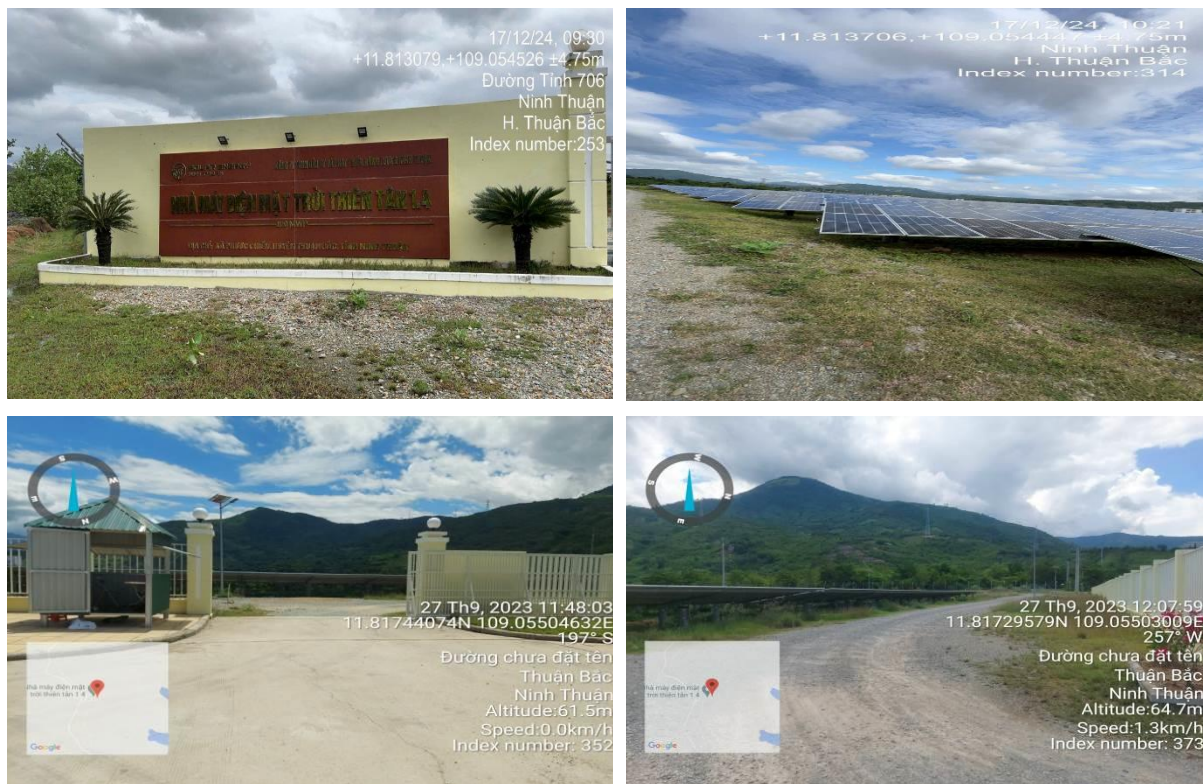
Hình 1.1: Hiện trạng khu vực cơ sở
