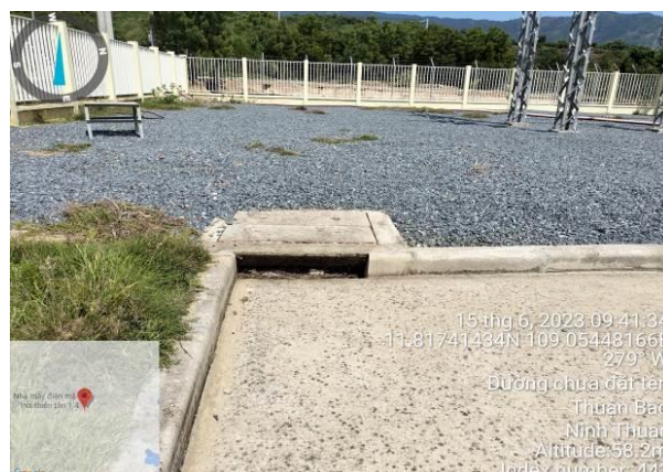
Hình 3.1: Hố ga thu gom nước mưa của Cơ sở
