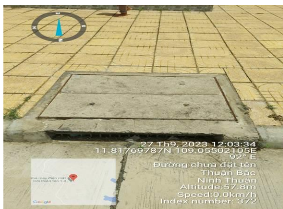
Hình 3.1: Hố ga thu gom nước mưa của Cơ sở
