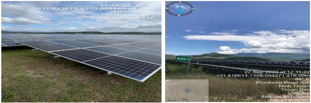
Hình 1.7: Khu bố trí tấm pin năng lượng mặt trời của Cơ sở
